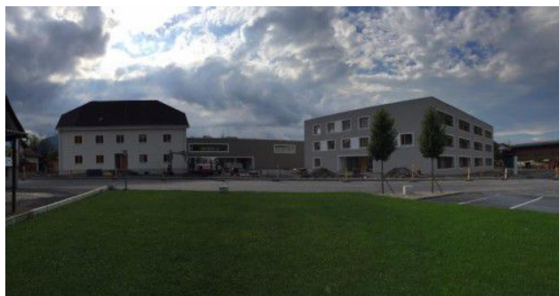
Das frühere Koblacher Versorgungsheim wurde generalsaniert und zwei Neubauten errichtet.
